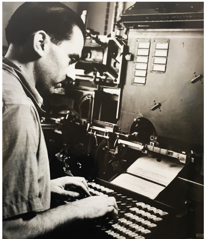
Figure 26.1 e 26.2 Intertypisti nella Franciscan Press , circa 1960, al lavoro mentre battevano sulla tastiera della macchina fonditrice-compositrice il testo da riprodurre; da ASCTS, Fondo fotografico p. Faccio, album 3-4.
