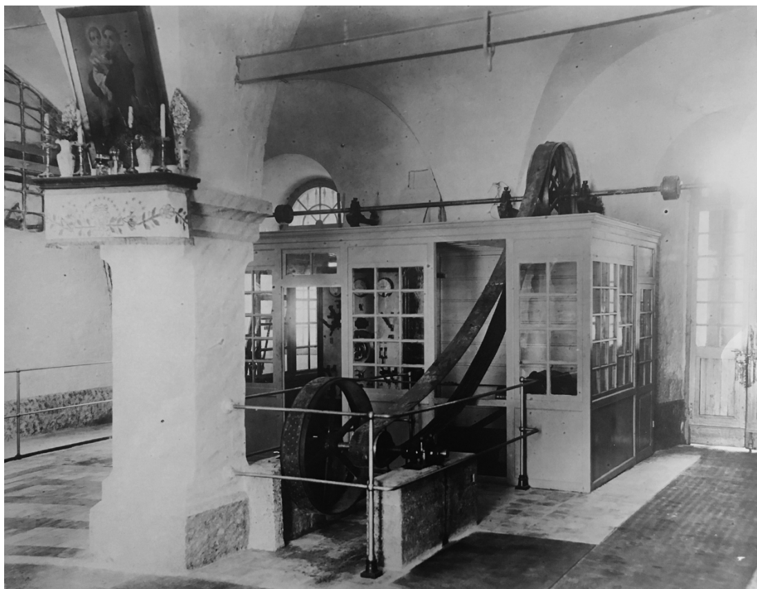
Figure 1 e 3.2 Le cinghie di trasmissione legate all'albero motore mettevano in movimento i macchinari delle officine di San Salvatore a inizio '900 (in ASCTS, Fondo fotografico 16, Officine, S. Salvatore)
