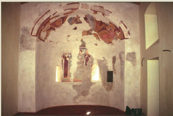
Facciata a capanna della chiesa (sopra). Abside romanica (sotto).
