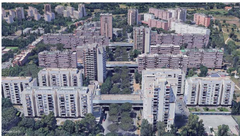
Fig. 1 – Alcune insulae del Laurentino 38, 2015
