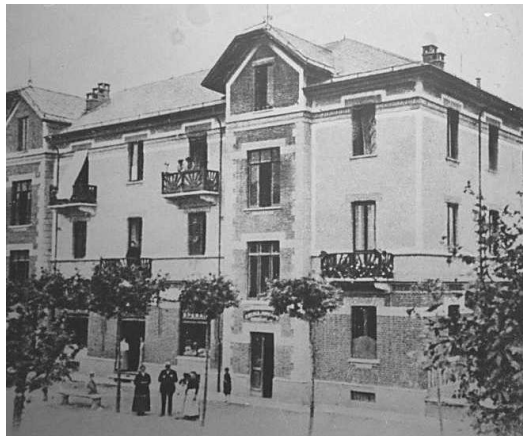
Immagine 10 - Spaccio aziendale e dopo-lavoro dipendenti - Villaggio Leumann 62
